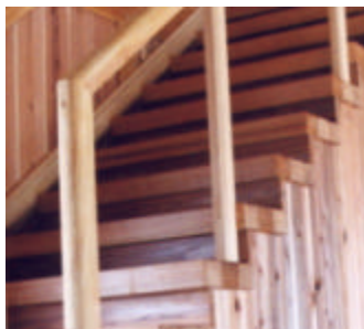
写真 2 階段施工例 手摺り・手摺り子 75 x 75mm 桧 丸面取り
